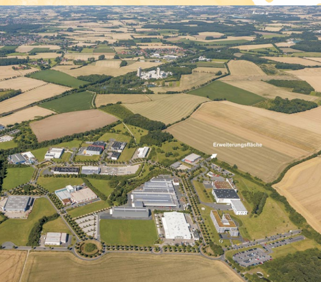
Luftbildaufnahme des Natur- und Gewerbeparks mit Erweiterungsfläche (Pfeil)
