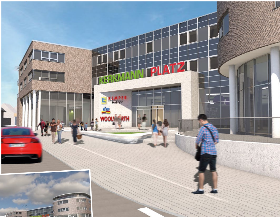
Noch in diesem Jahr ist es so weit: Der „Kerkmann-Platz“ wird seine Türen öffnen. © Visualisierungen: Lohmann Architekten
